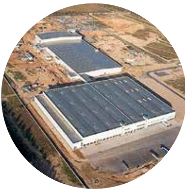
Кондитерская фабрика Ferrero Rocher во Владимирской области. В качестве теплоизоляции плоской кровли применялись плиты двойной плотности ROCKWOOL РУФ БАТТС ОПТИМА
