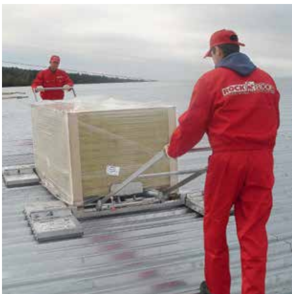
Применение тележек lift & roller на 50% повышает скорость монтажа
